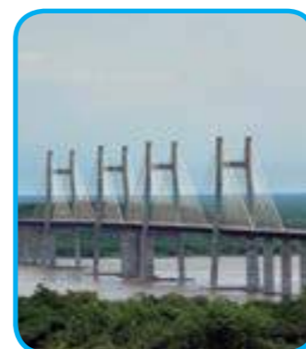
Puente Orinoquia, estado Bolívar.
